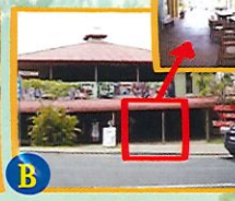
B 建物内を抜けるとマーケット
